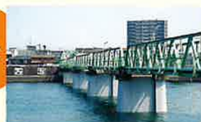
熊本県八代市前川橋
