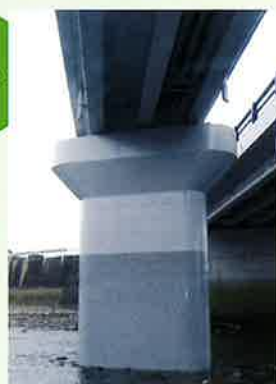
佐賀県太良町新糸岐歩道橋
